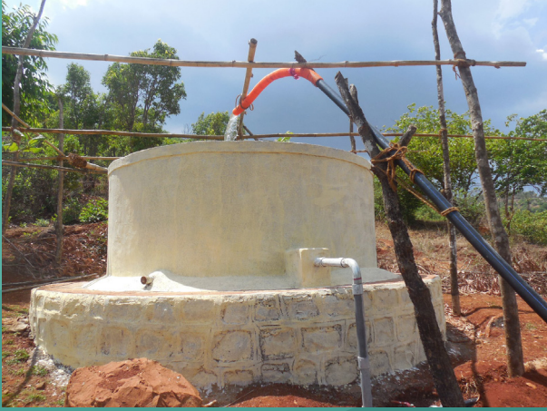
▲ फेरोसिमेंट टाकी, पाणी साठवण टाकीचा वेल्हे तालुक्यातील पहिला प्रयोग
